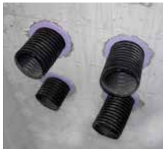
Widok od wewnętrznej strony budynku, widoczne pierścienie centrujące
