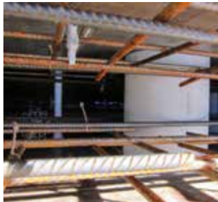
ZVR 200/300 zabudowana w szalunku
