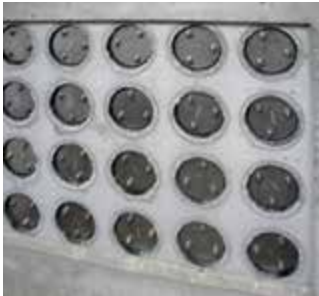
FZR 100/240 po zabetonowaniu, zaślepione gumowymi wkładami zaślepiającymi
