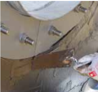
HRD 300-FUF/300 wykonanie ze stali nierdzewnej, w połączeniu z PMBC poprzez podkładkę, patrz str. 37
