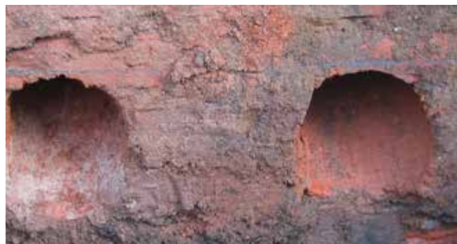
Otworowanie kątowe ściany murowanej.
