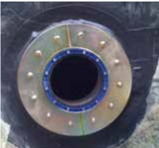
HRD 300-FUF/300-vz zastosowanie gumowego wkładu uszczelniającego HSD-C (malowanego proszkowo)
