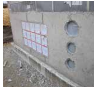
ZVR 150/300 i ZVR 200/300 zabetonowane obok przepustów HSI 150
