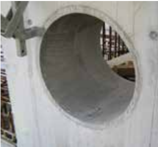
FZR 400/300 zabetonowana w zbiorniku oczyszczalni ścieków
