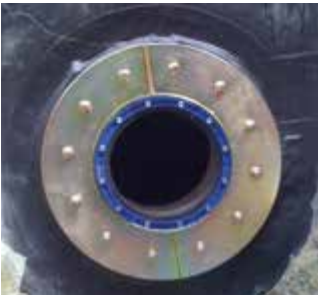
HSD-C 200/159 w zabetonowanej rurze przepustowej z kołnierzem
