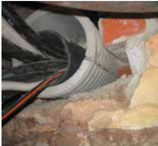
FZR-G 150/350 montaż w ścianie ceglanej
