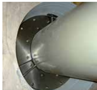
HRD 600-2G-1/420 ex 50 uszczelnienie nieosiowe, minimalna grubość 50 mm
