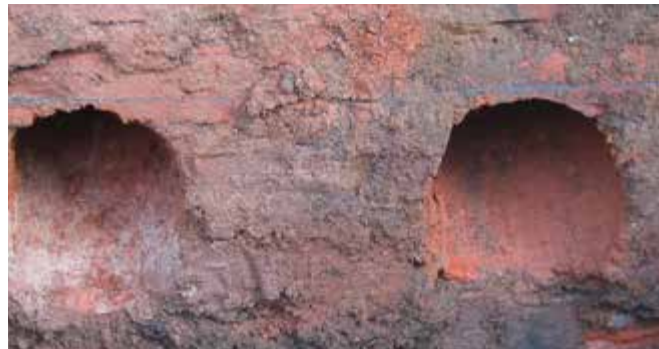
Otworowanie kątowe ściany murowanej.
