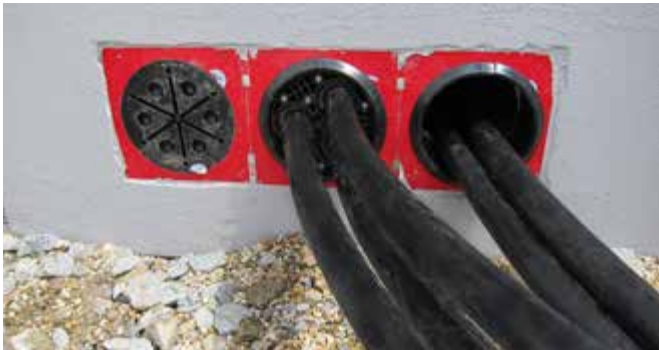
Różne fazy instalacji systemu HSI 150-DG-3/24-54
