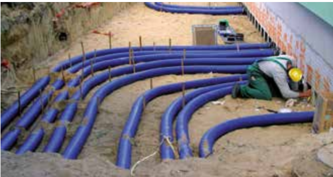
Szczelne połączenie węża Hateflex 14150 z pokrywą systemową HSI 150
