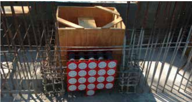
Podwójne przepusty kablowe HSI 90-K2 przed zabetonowaniem
