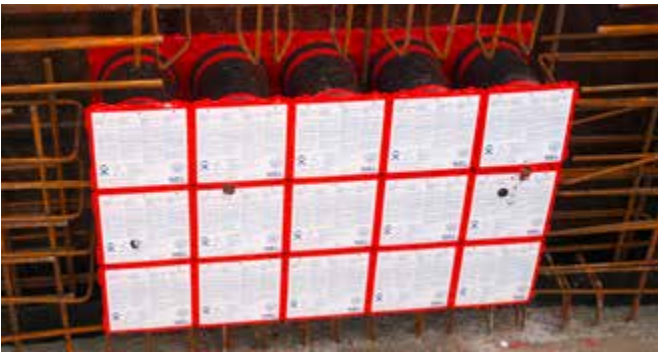
Pakiet podwójnych przepustów HSI 150 zamocowany w szalunku
