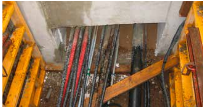
Prostokątny istniejący otwór, uszczelnienie kabli już ułożonych.
