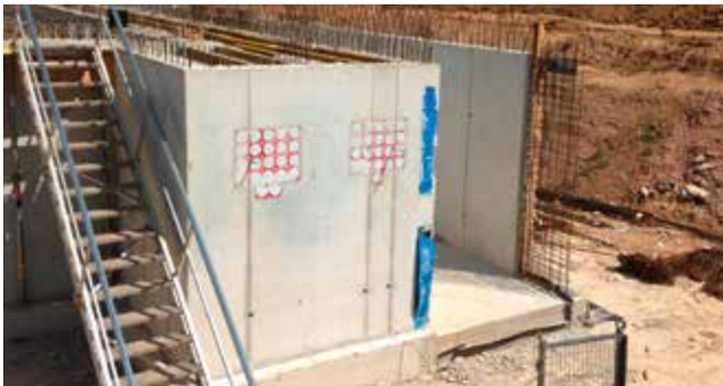
HSI 90-K2 po zabetonowaniu
