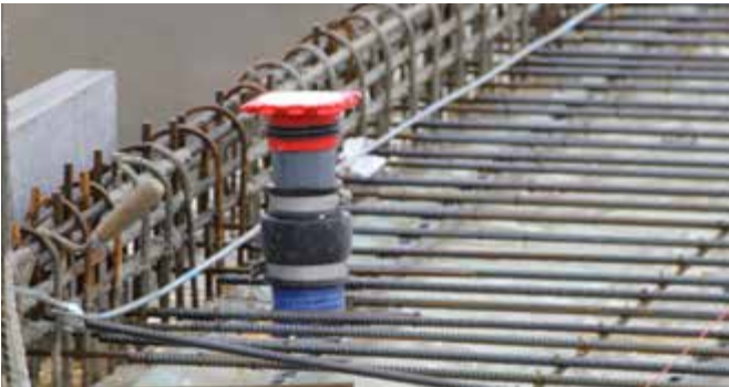
KES-M 90-KVB – instalacja w płycie
