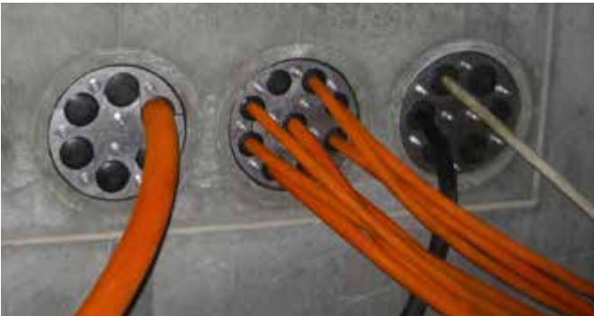
HRD 150-SG uszczelnione kable w odwiercie w ścianie betonowej
