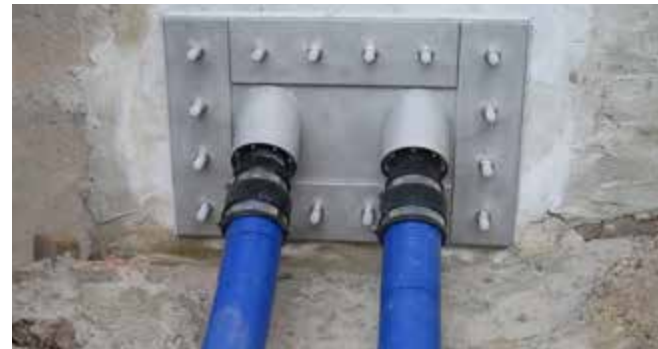
Zastosowano kołnierz stalowy z ukośnym podejściem i gumowymi wkładami uszczelniającymi.
