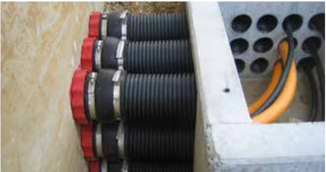
Uszczelnienie rur karbowanych metodą opasek zaciskowych HSI 150-M 168
