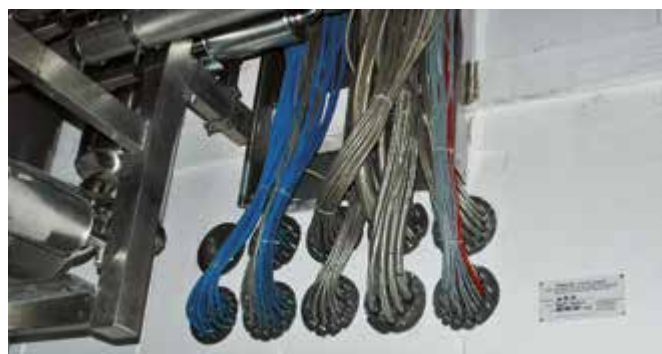
HRD 150-1G uszczelnienie wielu kabli w odwiercie
