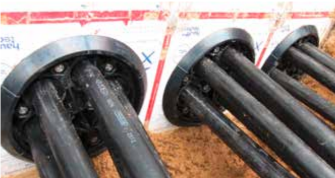
Kable uszczelnione przy pomocy HSI 150-DG-6/10-36
