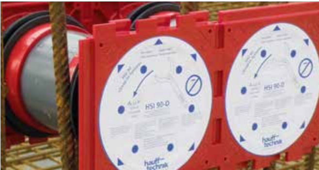
Podwójny przepust HSI 90 zamontowany w szalunku
