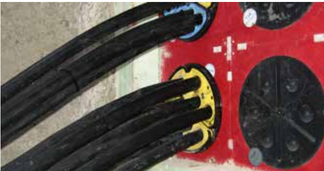
Uszczelnienie kabli oświetlenia ulicznego z zastosowaniem SEG-MENTO
