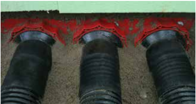
Uszczelnienie rur karbowanych metodą zimnokurczliwych opasek HSI 150-D 110-KS
