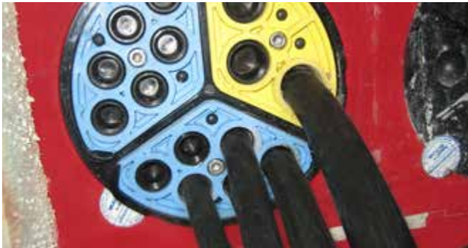
HSI 150 - SEGMENTO – zabudowany system kontroli momentu obrotowego oraz fabryczne zaślepki
