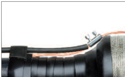
Połączenie z wyprowadzeniem uziemienia
