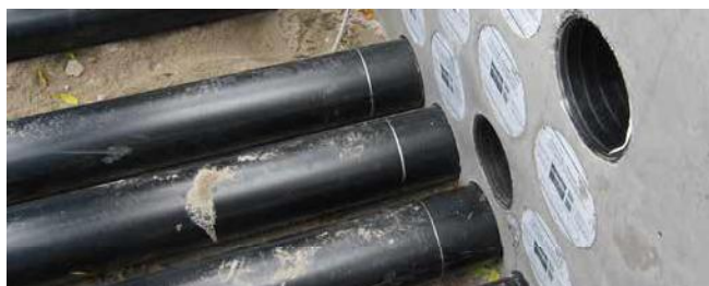
HSI150 GSM Varia połączone w pakiet i zabetonowane
