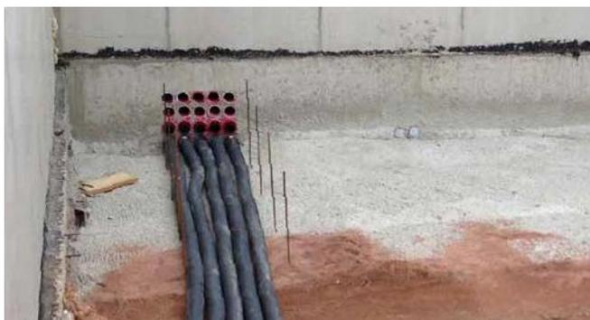
rury karbowane uszczelnione pokrywami systemowymi HSI90 D1x75 KS WR
