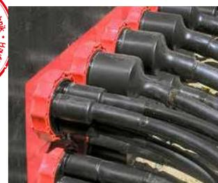
stacja kontenerowa: kable niskiego napięcia uszczelnione za pomocą
